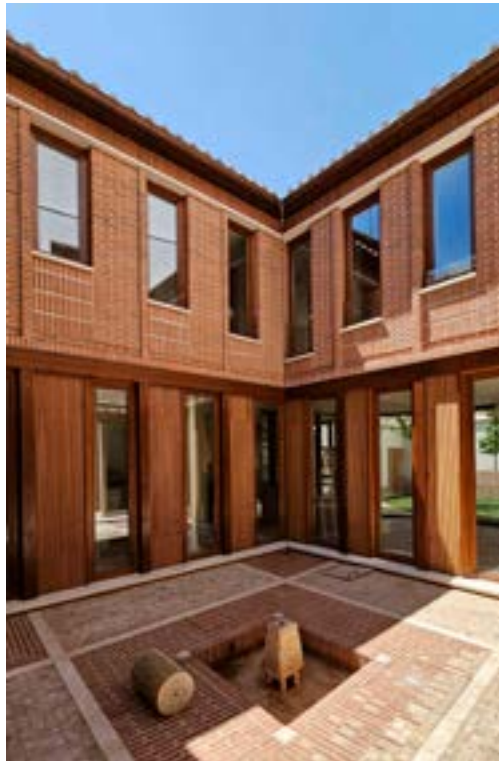
RECUPERACIÓN DEL PATIO CENTRAL: FACHADAS NUEVAS Y PAVIMENTO
