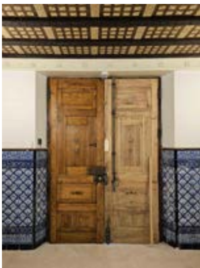
Premio Ciudad de Alcalá de Arquitectura 2025 Santiago 27 Rehabilitación de un edificio residencial para cinco viviendas
