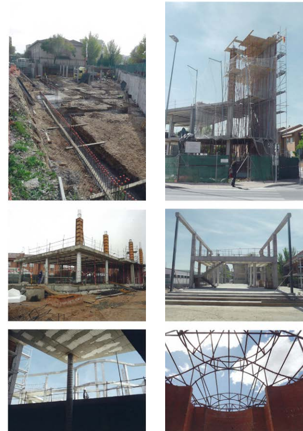
Iglesia Ortodoxa Rumana de San Jorge Mártir Trabajos de construcción Cuesta de Teatinos, 12. Alcalá de Henares
